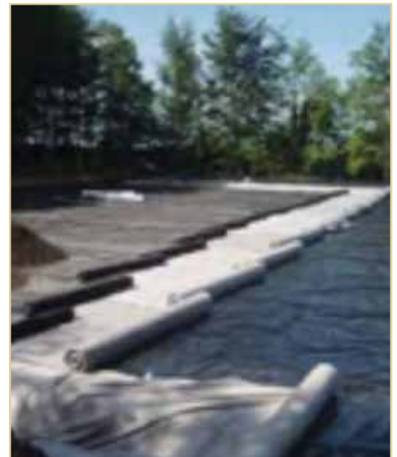
Fig. 7.- Foto de las membranas de protección que se sitúan en los emplazamientos de las torres de perforación
